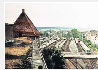
Blick Richtung Bahnhof vom – inzwischen nicht mehr überwachten – Dach der Kulturfabrik. FOTOS (4): JÄKEL
