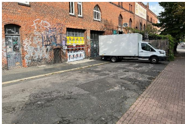
Rampe (hinter der Terrasse)
